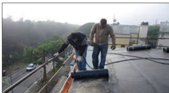
Impermeabilizzazione con guaina bituminosa
